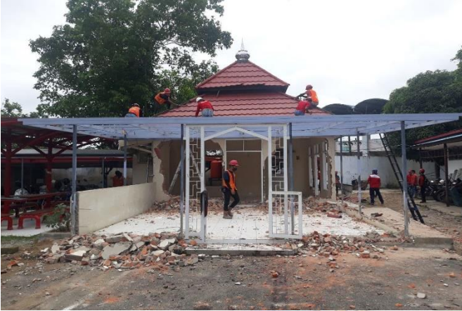
➤ Renovasi Musholla Ar-Riyadh
