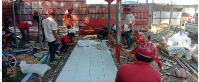
➤ Renovasi dan Pemindahan Wico Telkom Dahlia
